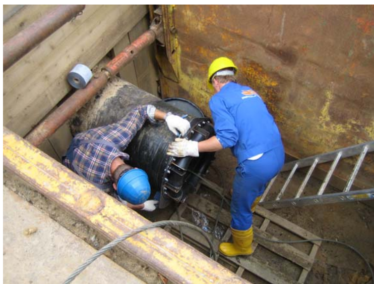
Abbildung 3: Montage der Führungsrollen am Altrohr
